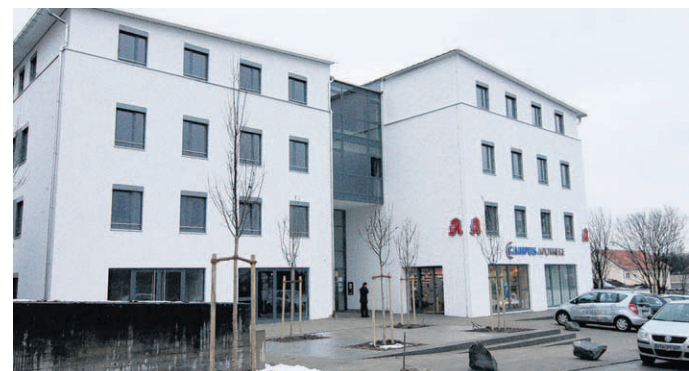
Auf 4500 Quadratmetern bietet der Medizin Campus Erding die gebündelte medizinische Fachkompetenz. Derzeit entsteht noch der Übergang zum Kreiskrankenhaus.
